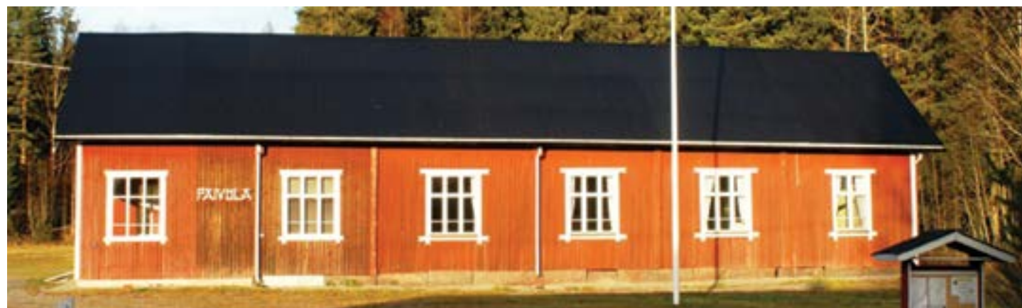
Leväsjoen Kylätalo Päivölä sai Suomen Kotiseutuliitolta avustusta 10.000 € ulkoseinien kunnostamiseen ja maalaukseen. Lähes 120-vuotiaan talon katto korjattiin viime vuonna ja rapistunut julkisivu ehostuu nyt vuorostaan tänä kesänä.
