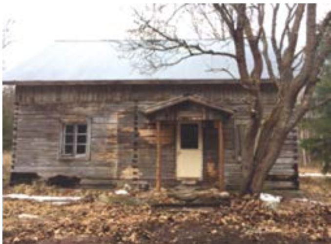
Kevät 2018: kuisti purettu, katos rakennettu, piharakennuksia korjailtu, pihaa pöyhitty.
