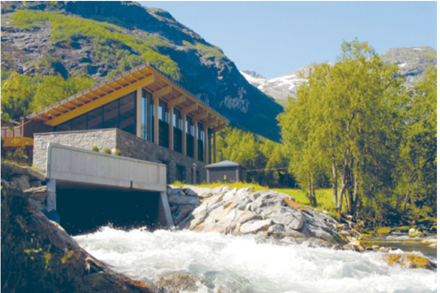
Lankosken Sähkö Oy omistaa norjalaisesta Litlebon vesivoimalaitoksesta 15.5. 2020 alkaen n. 3 %. Kuva lehdistötiedote.
