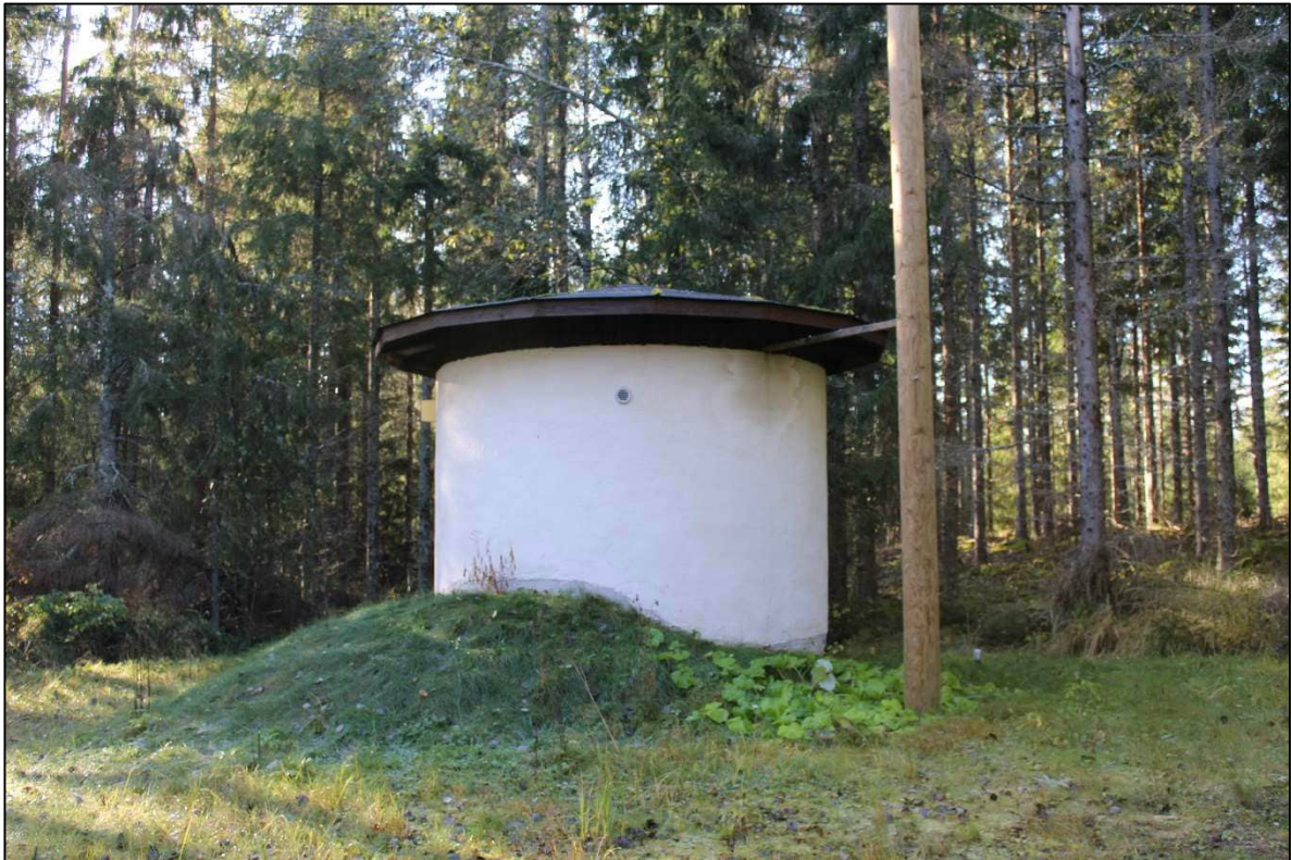
Kuva 3. Kernikanta II vedenottamo Marjamäenkankaan pohjavesialueella.
