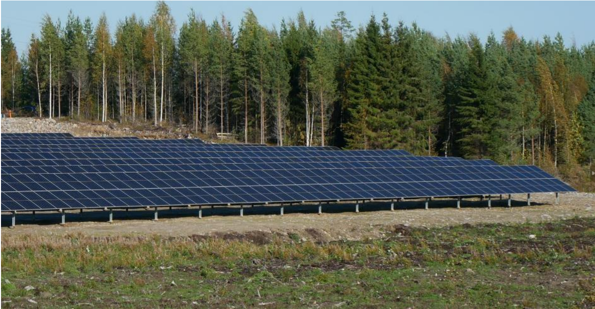
Kuva 6. Yleinen periaatekuva hankealueella käytettävistä aurinkokennoista.
