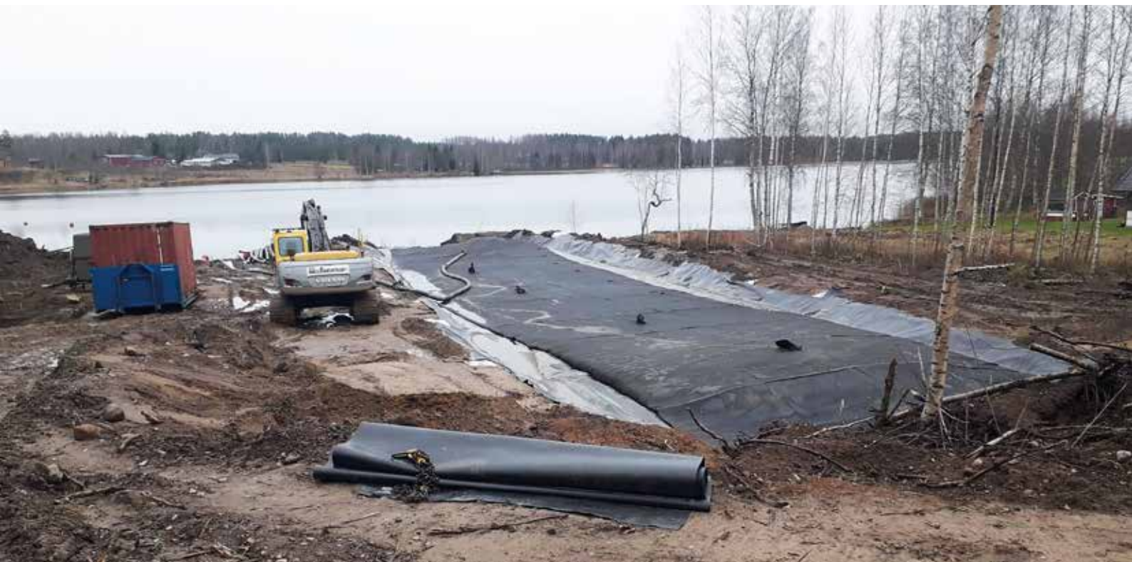
Geotuubikentän valmistelu. Kuva: Rainer Jönkkäri
